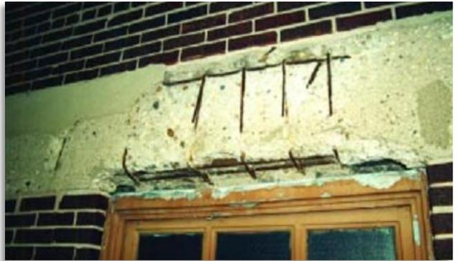
من المعروف أن التآكل هو تفاعل أكسدة أي أن المعدن يفقد إلكترونات ويطلق أيونات موجبة يقابله تفاعل إختزال أي إكتساب للإلكترونات المفقودة من الأنود وبالتالي حدوث ترسيب للمعدن ، و يحدث التآكل عند توفر عوامل معينة وهي :
