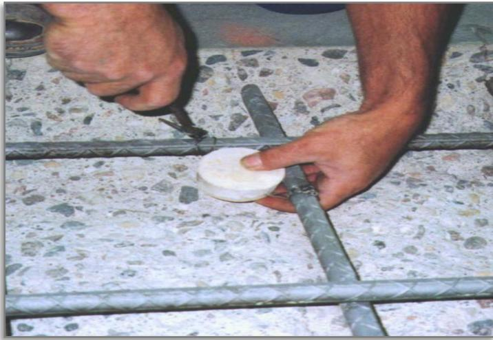
• الحماية بتسليط تيار كهربائي مستمر ( Impressed current ) في دائرة كهربائية بحيث يكون الحديد فيها كاثودا كما هو موضح بالشكل :
